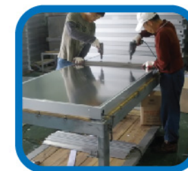
집열기 조립 완성 Completion of solar collector assembly
