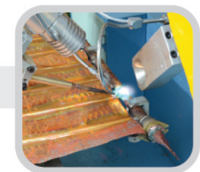
주관 지관 자동용접 Automatic welding of main pipe and branch pipe
